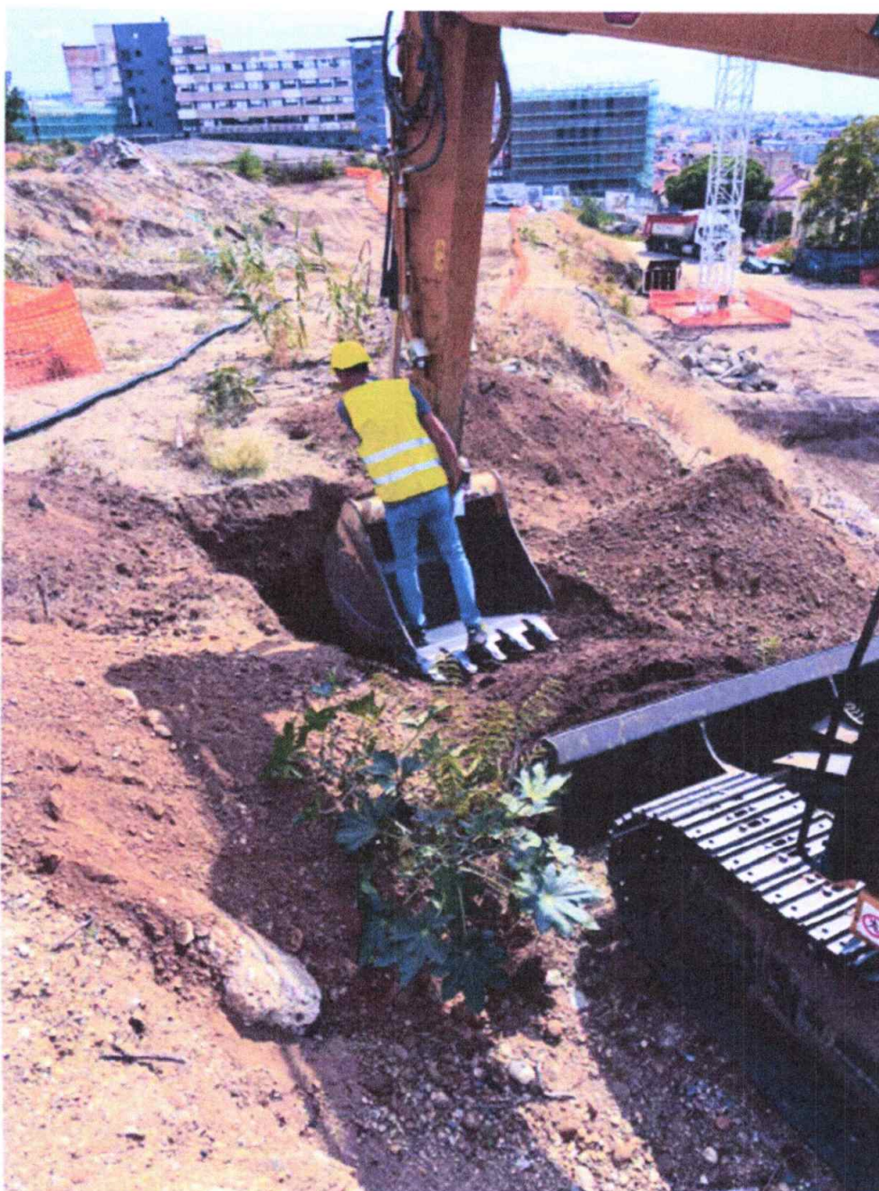
Realizzazione trincea di prelievo
